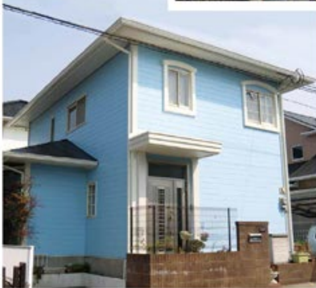
外壁：スーパー無機ガード／屋根：遮熱塗装
